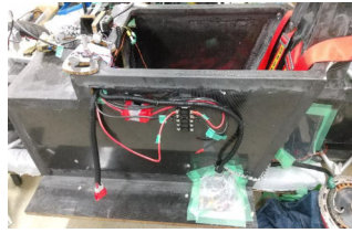
新車体への配線
