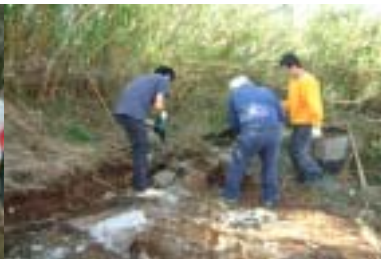
11.17 基礎取り壊し
