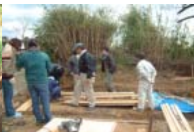
1.13 基礎型枠作業
