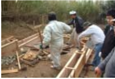
1.19 基礎型枠作業
