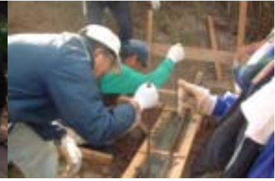
1.26 基礎コンクリート打設
