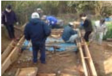
1.19 基礎型枠作業
