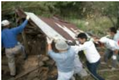
10.5 既存小屋取り壊し
