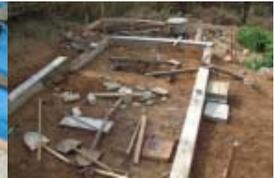
1.26 基礎コンクリート打設
