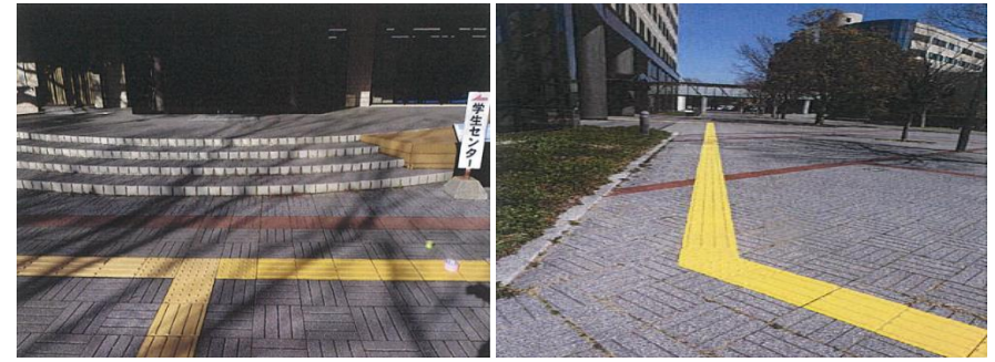
【点字ブロック施工写真（左：附属図書館前、右：システム工学部 A 棟前）】
