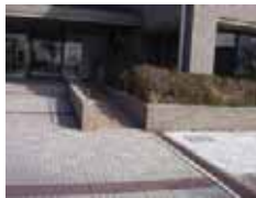
大学会館:昇降路の再整備
