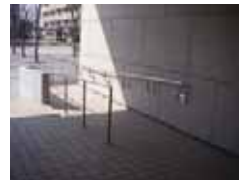
基礎教育棟:昇降路の再整備
